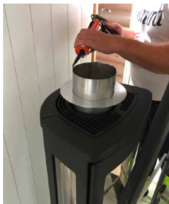
Kamiinan liitoksessa piippu asennetaan kantamaan sisäputkesta, jolloin piippumoduuli ei peitä kamiinan ilmakiertoa.
