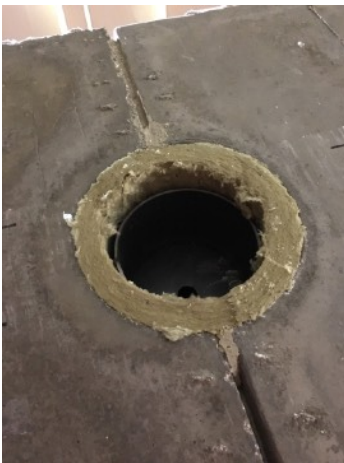
Tulisijan kannen päältä otetaan ilman kiertoa estävät eristeet pois.
