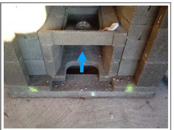
Mikäli kyseessä on vuolukivi takka, on huomioitava että liitoskappale tulee kantaa sisäputkesta, jolloin tukilevy asennetaan liitosyhteen sauman yläpuolelle.
