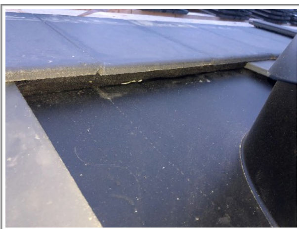
Asenna tiilet liimapintaan kiinni kauttaaltaan siten että vesi valuu pintojen yli.
