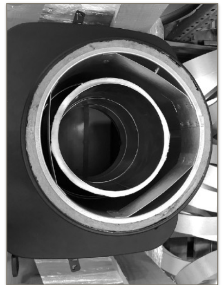
Alkuliitos on valmis ja voit kasata loput piippumoduuleista normaaliin tapaan.
