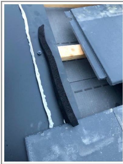
Asenna liiman ulkopuolelle tiivistenauha lisävarmistukseksi.
