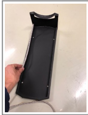
Kiinnitä tuloilmakanavaan tiivisteet
