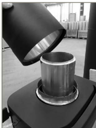
Asenna eristetty moduuli savuputken ja Nodpeis liitoskappaleen päälle. Varmista tiiveys palomassalla.
