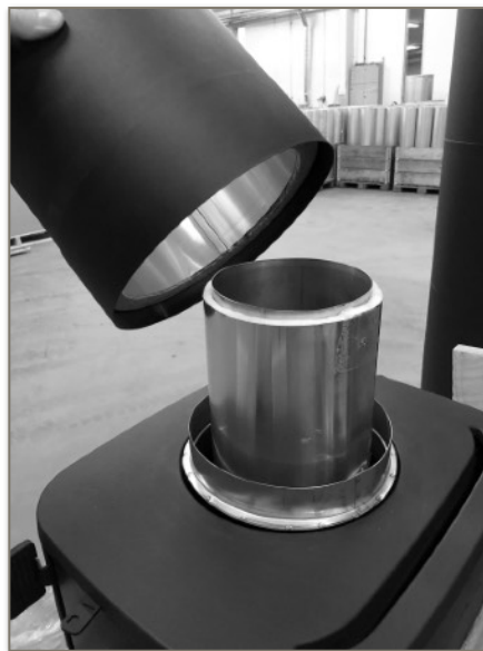
Asenna tuloilmapiipun ulkokuori savuputken ja liitosadapterin päälle.
