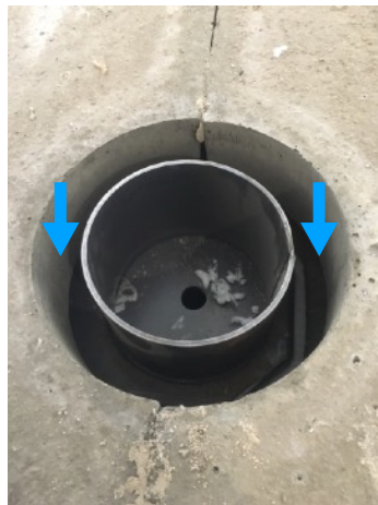
Piipun ja kannen välinen liitos tiivistetään mahdollisimman tiiviiksi tiivistenauhalla.
