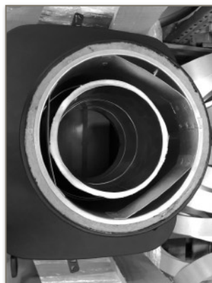
Liitos on valmis ja voit jatkaa piipun asentamista Härmä Air asennusohjeen mukaisesti.
