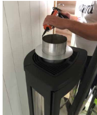
Kamiinan liitoksessa piippu asennetaan kantamaan sisäputkesta, jolloin piippumoduuli ei peitä kamiinan ilmakiertoa.
